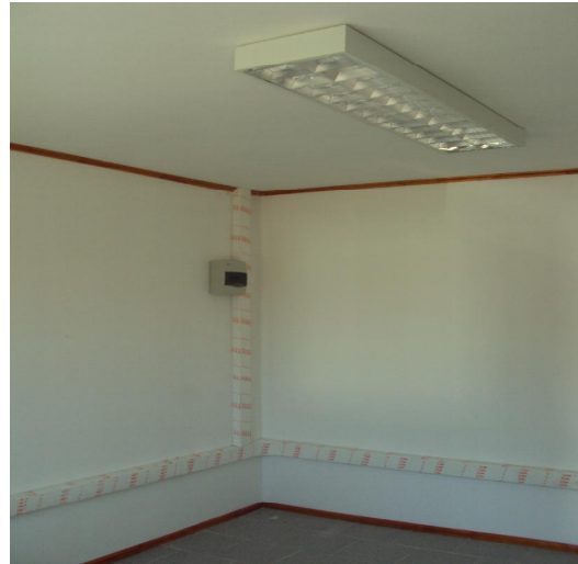
Interior Oficina Aseo después del Proyecto
