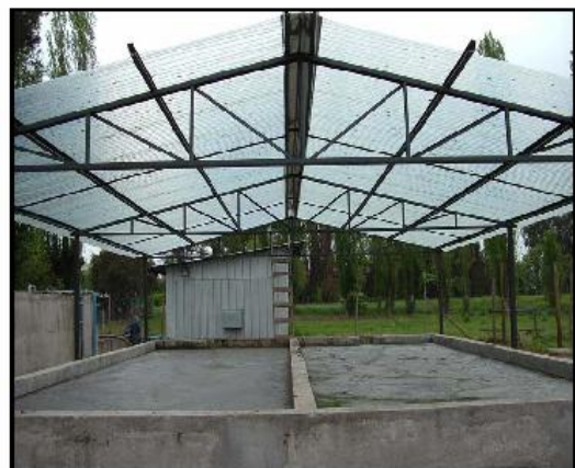
Vista frontal del techo cobertor de las Canchas.
