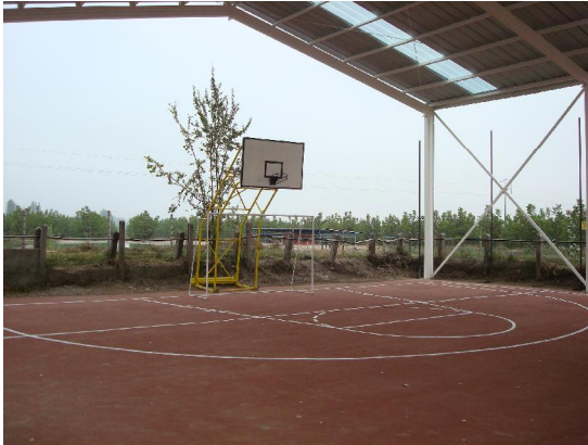
PROYECTO: "Construcción Techo Multicancha Liceo El Llano"
