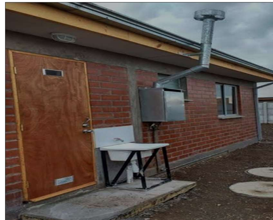
Vista del costado de la vivienda, lavaplatos exterior y calefont instalado con cubículo protector
