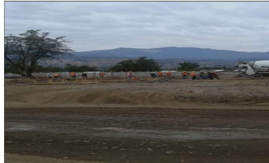
Marcado de los terreno y fundaciones de las viviendas.
