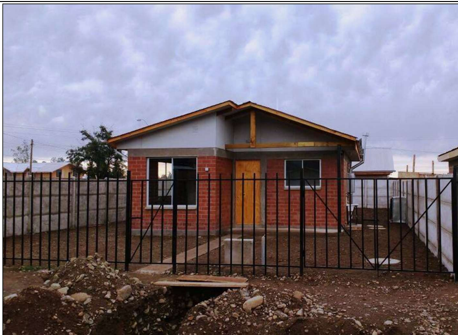
Resultado final, viviendas ya construidas en su totalidad, incluidos sus cierres perimetrales.
