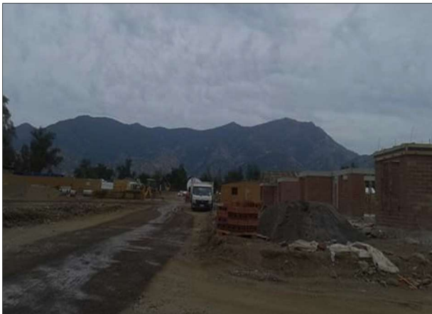
Construcción de calles y viviendas avanzan muy rápidamente
