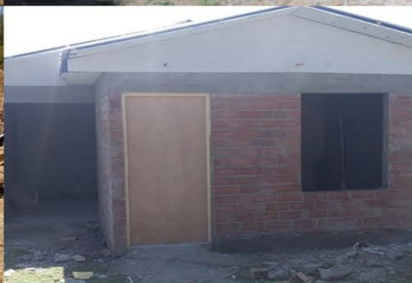
CONSTRUCCIÓN EN SITIO PROPIO diferentes etapas que ha tenido la construcción en sitio propio. A la fecha se están construyendo 14 vivienda simultáneamente, de un total de 40 familias beneficiarias en diferentes sectores de Pirque.
